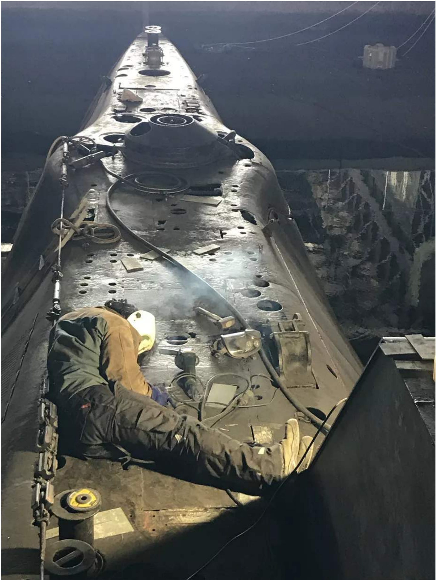
Les soudeurs s'activent autour du blindage de "L'Espadon" • © Christophe François / France Télévisions
